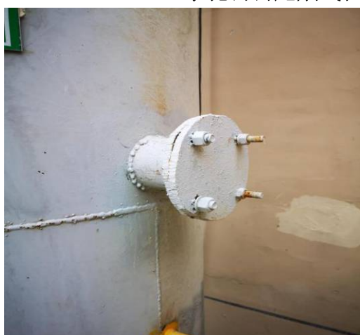
活性炭吸附装置排气筒监测孔和标识标牌
