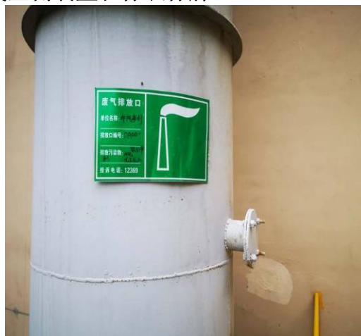
活性炭吸附装置排气筒监测孔和标识标牌
