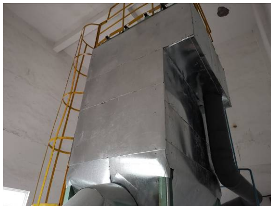
飞灰储存和输送车间布袋除尘器
