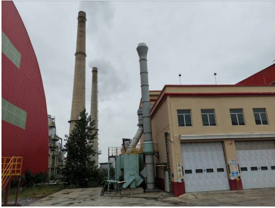
无机固废储存和输送车间备用活性炭吸附装置
