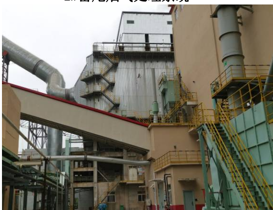
固废输送廊道布袋除尘器 1
