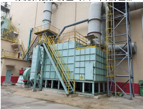
固废储存和输送车间备用活性炭吸附装置
