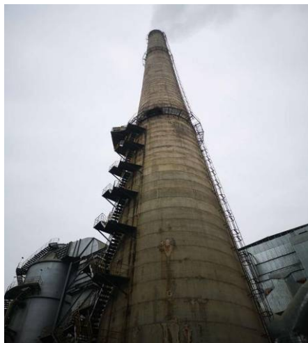
1#水泥窑窑尾烟气监测平台和监测孔
