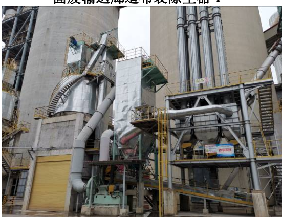
除氯系统旋风除尘+表冷+布袋除尘器
