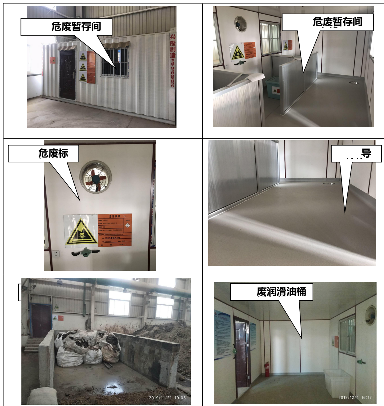
图2.7-4 危废暂存间设置情况
